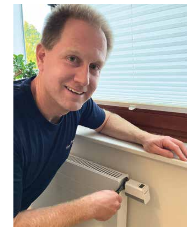
Kim Bödecker montiert ein Thermostatkopf für ein Smart-Home-System: Damit lassen sich die Heizkosten senken Foto: Tina Jordan
